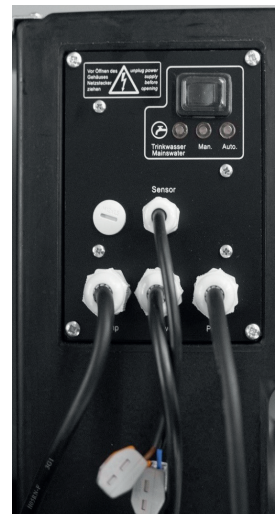
Abb. 8.8.1 Anschluss Tauchdrucksonde
