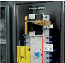
Abschließbarer TECGET Lasttrennschalter mit 3-poliger Phasenüberwachung
