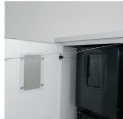
Extra Seilsicherung. Dadurch keine Überdehnung/Abbruch der Tür
