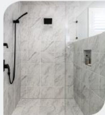
Temperierung der Duschwände
