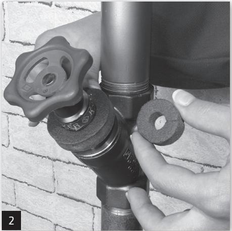
Wählen Sie den passenden Weichschaum-Adapter für den Spindeldurchmesser der Armatur.
