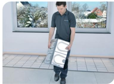
Elemente mittels Sollbruchstellen anpassen und Rand- und Eckbereiche mit Randelementen auffüllen. Niemals Aluminiumbleche schneiden!
