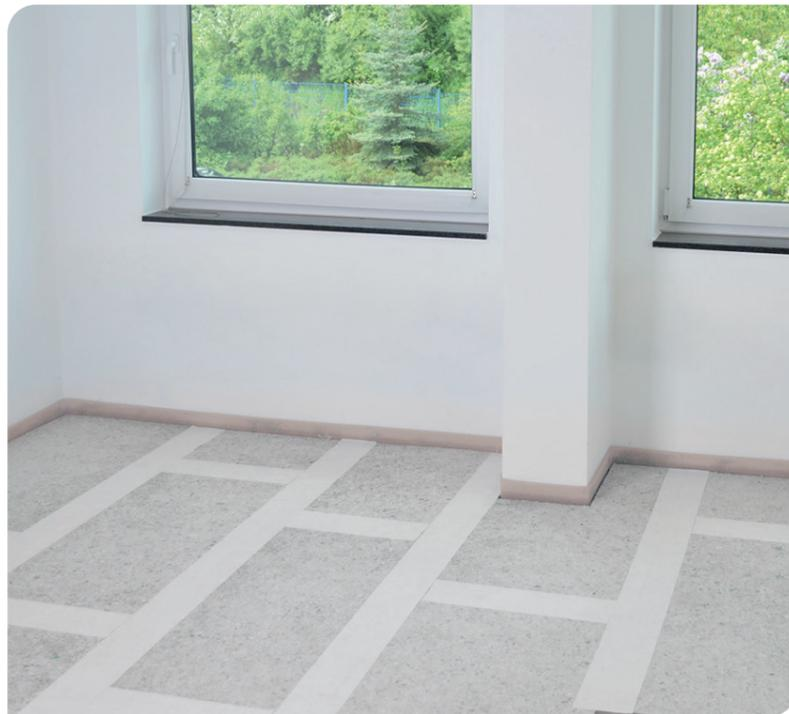
Die fertige Fläche vor Verschmutzung schützen, Laufwege ausreichend, z. B. mit Dämmplatten, abdecken. Der Oberboden kann direkt verlegt werden.
