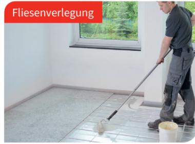
Strongboard FL bei Fliesenbelag vollflächig auf den Heizelementen mit Kleber, z. B. Rollfix Eco, fixieren.
