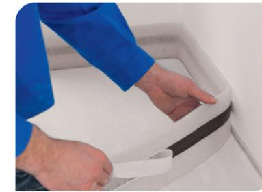
Randdämmstreifen an der Wand befestigen, Enden dürfen nicht überlappen. Höhe der Gesamtkonstruktion beachten.
