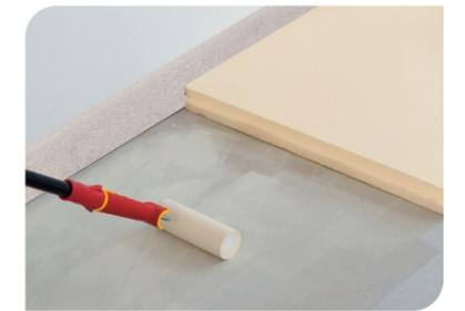
Bei Direktauflege-/ Strongboardkonstruktionen die Platten vollflächig fixieren und max. eine Schicht Zusatzdämmung verlegen.
