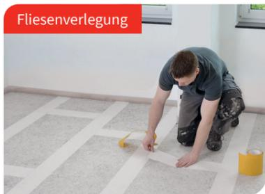
Bei Fliesenbelägen die Stoßstellen mit Fugenklebeband abkleben. Band darf nicht überlappen.
