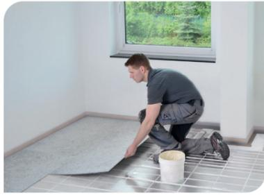
Die Verlegung erfolgt im schleppenden Verband. Der Fugenversatz muss größer als 20 cm sein – Kreuzfugen sind nicht zulässig.
