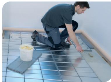
Bei leichten Konstruktionen (z. B. Parkett Direktauflage) müssen alle Elemente vollflächig mit Kleber, z. B. Rollfix Eco, fixiert werden.
