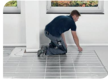
Mit Reststück ( $\geq 20$  cm) im schleppenden Verband beginnen (Fugenversatz  $\geq 20$  cm).
