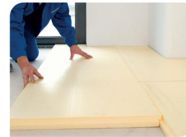
Dämmplatten auslegen. Platten im Verband, d.h. fugenversetzt und quer zur späteren Verlegung der COSMO-Elemente anordnen.
