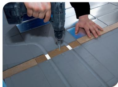
Im Türrdurchgang das Rahmenholz wenn möglich im Untergrund verschrauben. Übergangsschienen lassen sich so später leicht anbringen.
