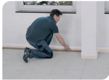
Randdämmstreifen auslegen und Rahmenhölzer auf sauberen, tragfähigen Untergrund verlegen.
