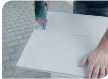
Letztes Element einer Reihe auf Länge kürzen (z.B. mit Kreissägeblatt Diamaster oder Stichsägeblatt T141 HM, Bosch).
