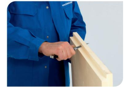
Stufenfalz bei den ersten Dämmplatten für einen vollflächigen und dichten Anschluss an Wand und Untergrund entfernen.
