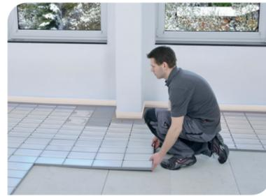
Heizelemente vollflächig auslegen. Zur Vereinfachung der Montage können die Kopfelemente mit z. B. Rollfix Eco fixiert werden.
