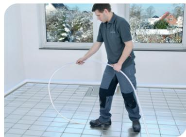
Aluverbundrohr in einem großen Bogen von oben spannungsfrei in die Rillen drücken. Maximale Heizkreislänge 100 m.
