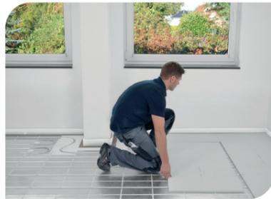
Das Element in der Nut-Feder-Verbindung zusammenschieben.
