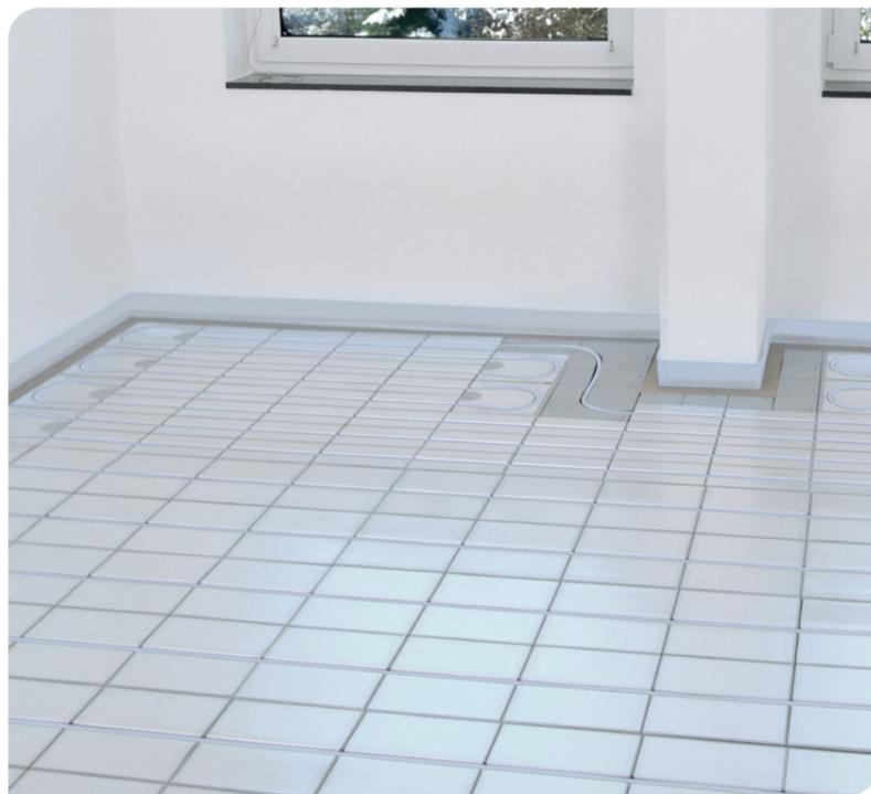
Fertig verlegte Fläche System COSMO TOP 20 – Bis zur Verlegung der Lastverteilschicht oder des Oberbodens Laufwege, z.B. mit Dämmplatten, vor Stauchung schützen. Es kann direkt weitergearbeitet werden.
