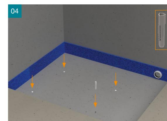
Löcher für die Bodenbefestigung bohren und Dübel einsetzen.
