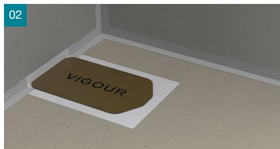
Bauseitige Dichtbänder mind. 5 cm überlappend auf die Dichtmanschette andichten.
