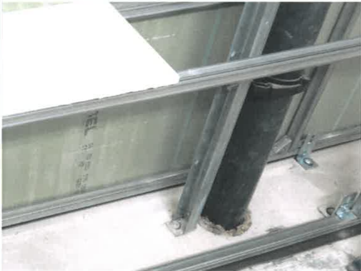
Bild rechts: Befestigung der Wand und Bodenprofile mit Entkopplung. Bild oben: Befestigung der Abwasserleitung an einer separaten Unterkonstruktion aus Ständerprofilen im oberen Wandbereich: "PHONOKLIP" Gleitschelle mit Abstandshalter. Bild Mitte: Befestigung der Abwasserleitung an einer separaten Unterkonstruktion aus Ständerprofilen im unteren Wandbereich: "PHONOKLIP" Festschelle Bild unten: In den Deckendurchbrüchen waren die Rohrleitungen mit weichfederndem Dämmstoff ummantelt. Details siehe Ergebnisblätter 1 bis 6.
