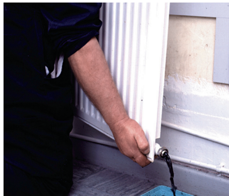
So sieht das „Blutbild“ einer Heizung aus, die behandelt werden muss.
