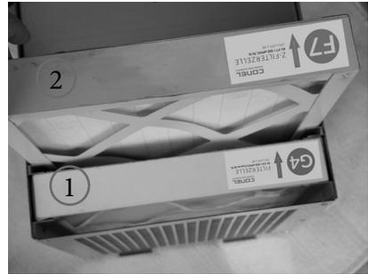
Der Luftfilter „Grob“ Klasse G4 sollte immer in Position (1) eingesetzt werden, der Luftfilter „Fein“ Klasse F7 muss immer in Position (2) eingesetzt werden.
